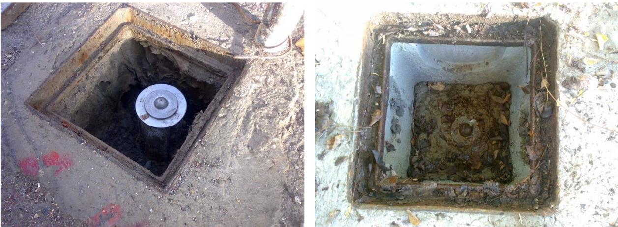
Monitoraggio viabilità e terreno superficiale e profondo – tubo inclinometrico e caposaldo di livellazione
