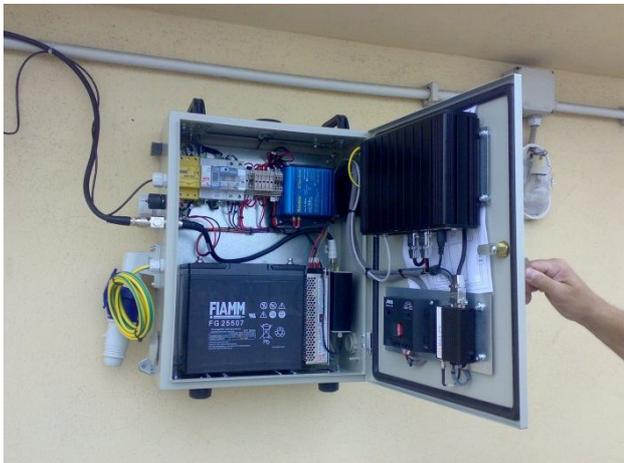
Stazione *MASTER* installata con apparati di comunicazione e computer industriali
