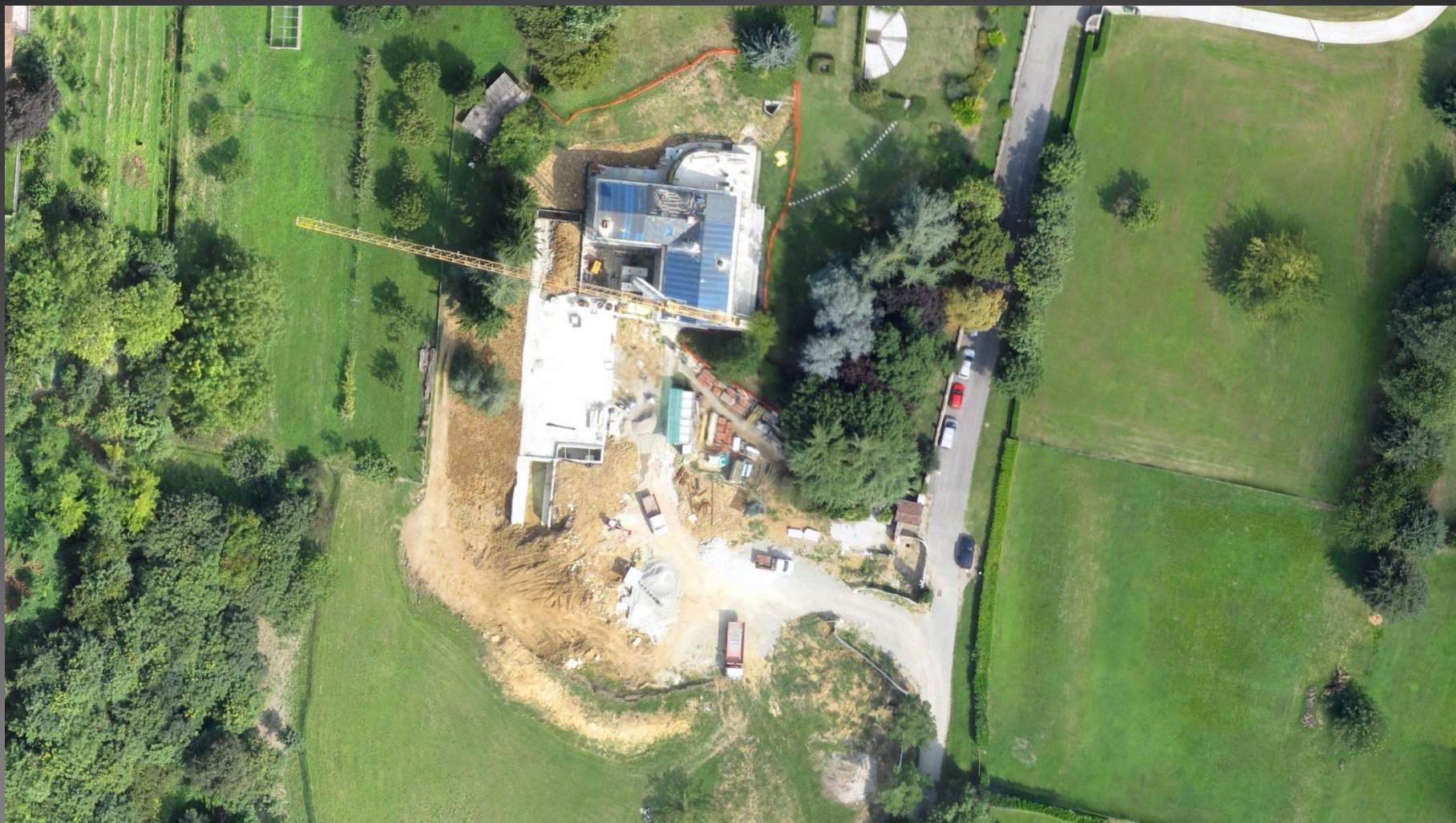
Aree di cantiere
